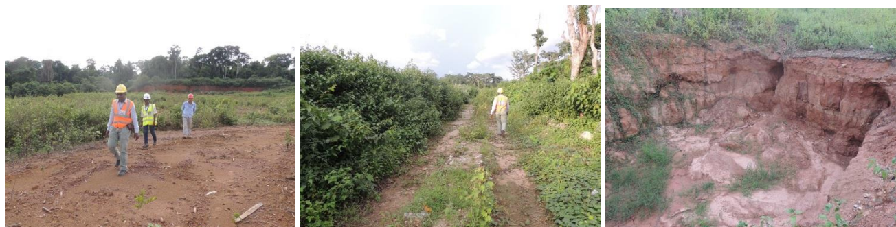
Figure 2-5: Mesures de réhabilitation
