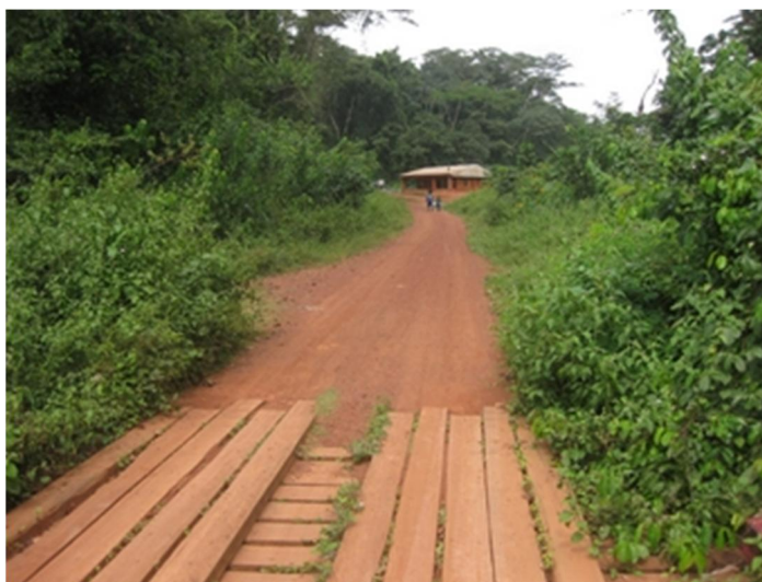
Figure 4-7: Poste de Mambaya (débouché d'une voie de contournement sur la gauche)
