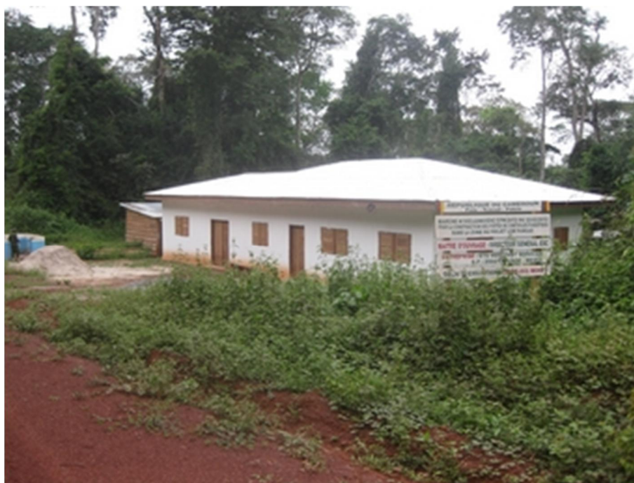
Figure 4-2: Poste de Lom Pangar – Rive Gauche
