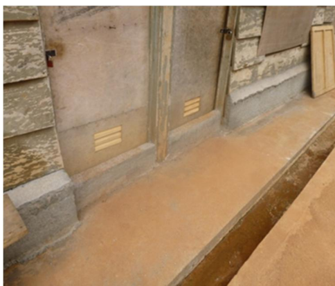
Aération et installations contre l'inondation à finir
