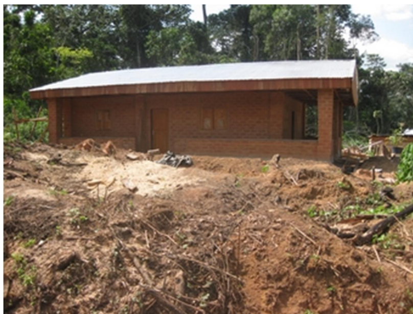
Figure 4-8: Poste de Mbiombe en construction
