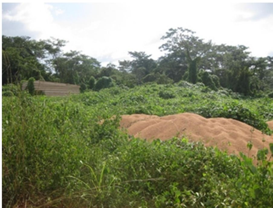
Figure 4-5: Chantier du poste de Lom 2
