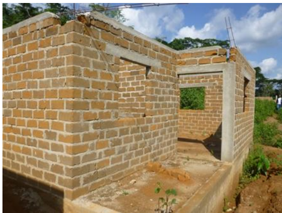
Figure 4-5: Le chantier de construction de Lom 2 bloqué
