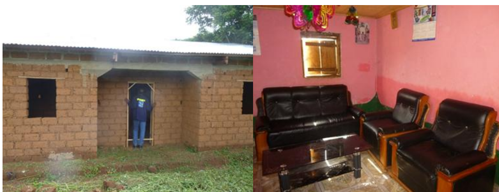
Figure 4-6: Maison en cours de construction et salon d'une maison finie
