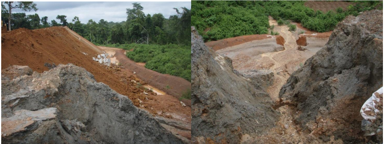
Figure 2-2: Décharge des boues du concasseur: digue
