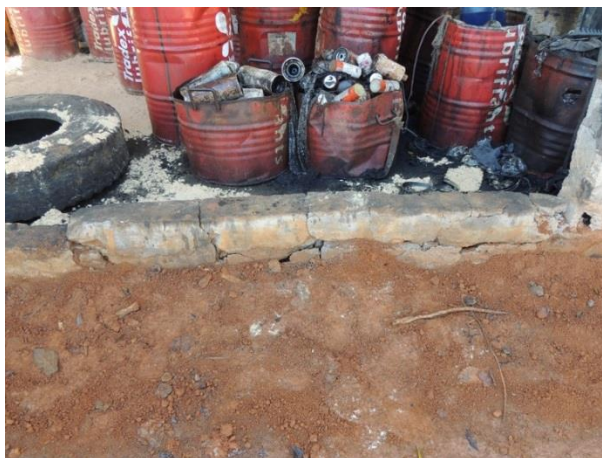
Figure 3-11: Dépôt d'huiles usées : seuil rempalcé et cassé de nouveau
