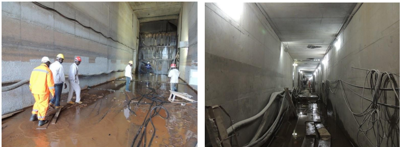
Figure 3-18: Accès à la galerie
