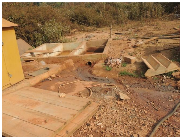
Figure 3-15: Boue contaminée déposée derrière le déshuileur
