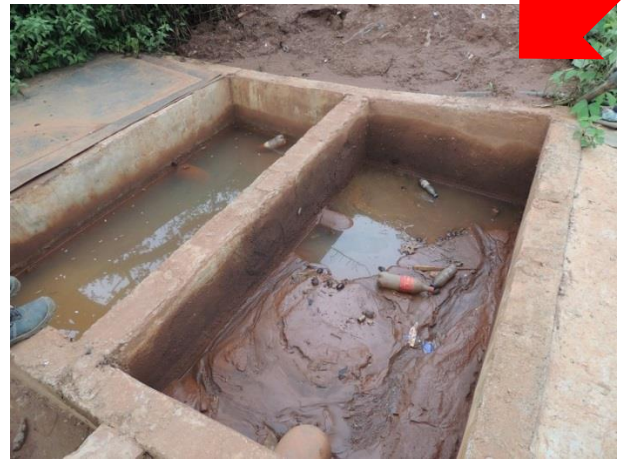
Figure 3-15: Boue contaminée déposée derrière le déshuileur
