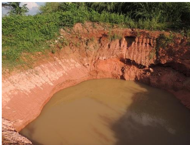
Figure 3-3: Fossé avec pentes très raides, piège potentiellement mortel
