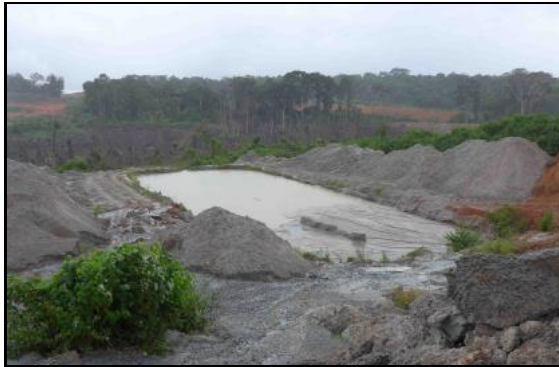
SITE CONCASSEUR : BASSIN 5 REMPLI DE SEDIMENTS ET DEPOT DES SEDIMENTS CURES AUTOUR DU BASSIN
