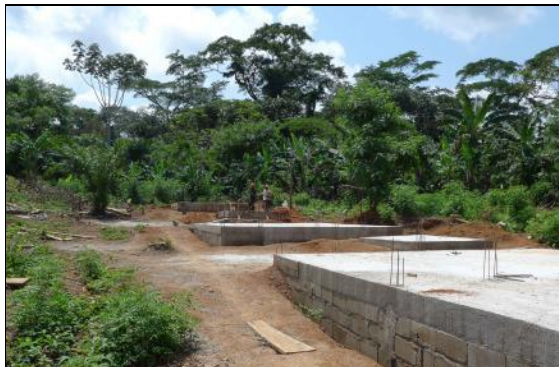
VUE DU CHANTIER
