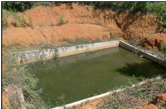
BASSIN ANAEROBIE DE TRAITEMENT DES LIXIVIATS
