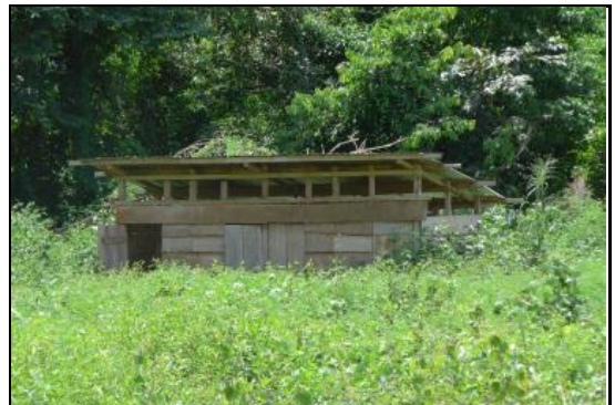
...AINSI QU'UN BATIMENT TOILETTES (A STABILISER AU PREALABLE)...
