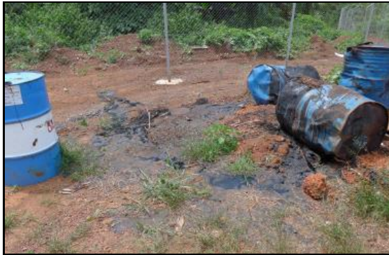
CITE MOA2 TOUJOURS SALE AVEC ECOULEMENT DE BITUME AU SOL,...
