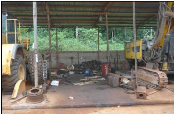
GARAGE CONCASSEUR DEVANT ETRE DEMOBILISE PROCHAINEMENT
