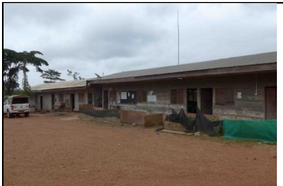
BASE VIE CONCASSEUR DEVANT ETRE DEMOBILISEE...
