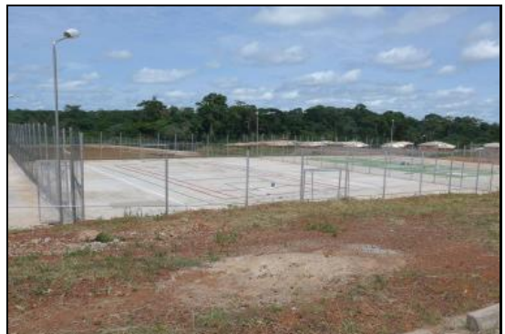
VUE DES INSTALLATIONS SPORTIVES DE LA BASE VIE MOA
