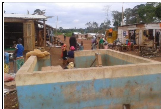
FORAGE DE OUAMI
