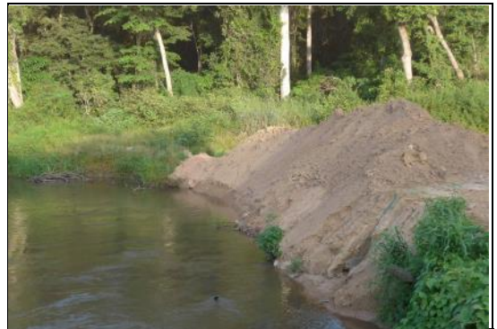
ET DEPOTS EVIDENTS DE PRODUITS DE TERRASSEMENT DANS LA RIVIERE
