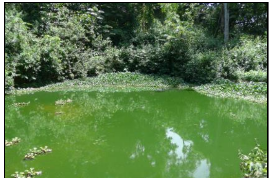
IDEM, BASSIN AEROBIE. PAS D'ÉCOULEMENT EXTERIEUR EN DEHORS DE LA SAISON DES PLUIES
