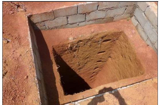
VUE D'UNE TOILETTE EN CONSTRUCTION (CHAQUE MAISON EST ACCOMPAGNEE D'UNE CUISINE EXTERIEURE ET D'UNE TOILETTE)
