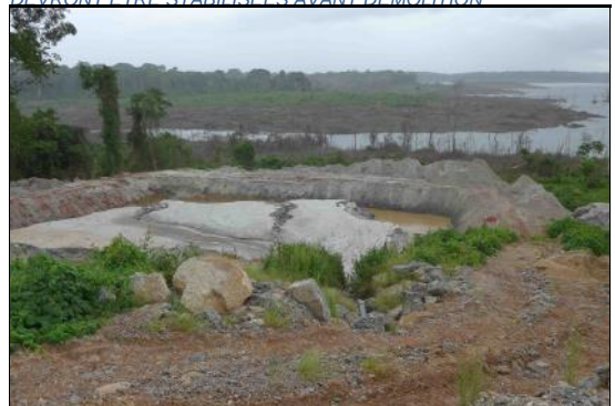
SITE CONCASSEUR : BASSIN 6 REMPLI DE SEDIMENTS ET DEPOT DES SEDIMENTS CURES AUTOUR DU BASSIN
