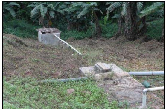
ET SON SYSTEME DE TRAITEMENT DONT LES BOUES DEVONT ETRE STABILISEES AVANT DEMOLITION
