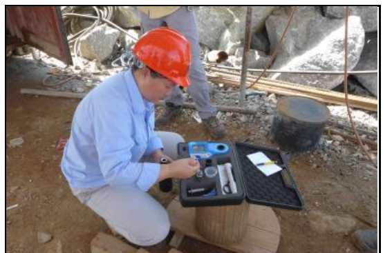
CONTROLE DE L'EAU DE BOISSON PAR CWE SUR CHANTIER BARRAGE
