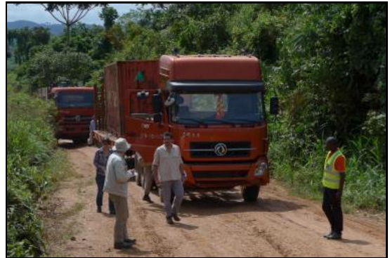
...ET ARRIVEE DES PREMIERS EQUIPEMENTS POUR LA CONSTRUCTION DU REMBLAI
