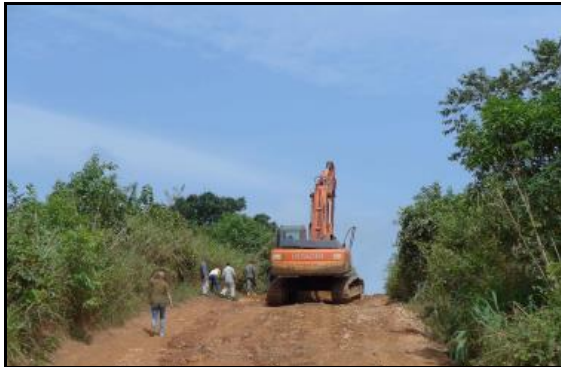
PETITS TRAVAUX DE CWE SUR LA ROUTE D'ACCES AU SITE DE TOURAKE...
