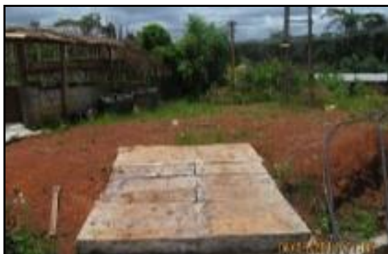
BVC: LE DESHUIEUR CANTINE EST BIEN DIMENSIONNE MAIS PAS ENTRETENU CAR FERME PAR DALLES BETON
