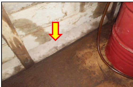
GARAGE CONCASSEUR: LOCAL HUILES NEUVES: ETANCHEITE SOL-MUR DEMANDEE EN JUILLET REALISEE
