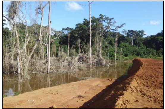
MAIS LE NIVEAU D'EAU N'A QUE PEU CHANGE (NIVEAU PRECEDENT DE LA DIGUE VISIBLE A GAUCHE) .....
