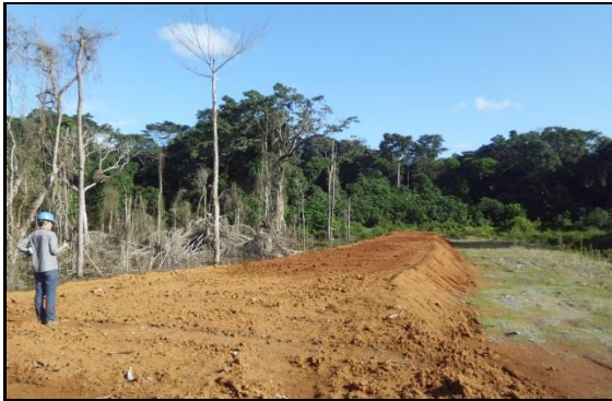
LA DIGUE DE FERMETURE DU BASSIN DE SEDIMENTATION CONCASSEUR A ETE REHAUSSEE DE 2M
