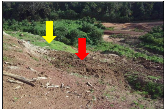
UN GLISSEMENT DE TERRAIN (FLECHE ROUGE) A PARTIELLEMENT RECOUVERT L'ESSAI DE REVEGETATION (FLECHE JAUNE)
