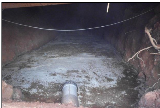
EN CONSEQUENCE, LE BASSIN ANAEROBIE QUI SUIV EST REMPLI DE GRAISSES ET ....
