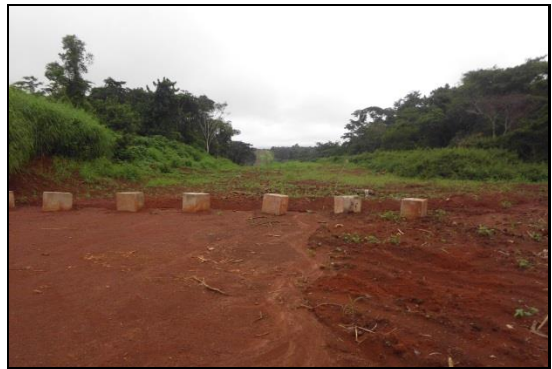
LA ROUTE A ETE COUPEE ET SA PARTIE NON FONCTIONNELLE SCARIFIEE ET REVEGETALISEE
