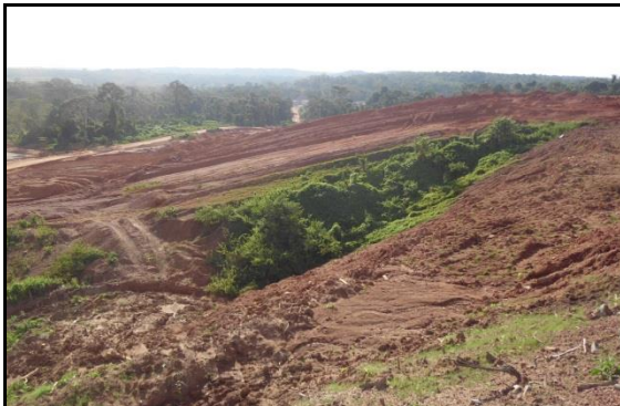
DEPOT NO 4: TRAVAUX EN COURS ET PETITS ESSAIS DE REVEGETATION (PASPALUM SP.) AU PREMIER PLAN.
