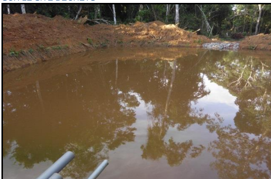
...LE BASSIN D'OXYDATION DES LIXIVIATS
