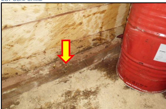
GARAGE PRINCIPAL, STOCKAGE HUILES NEUVES: ETANCHEITE SOL-MURS REALISEE.
