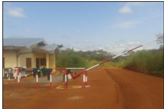
POSTE OCCUPE COTCO NORD
