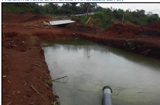
....LE BASSIN D'OXYDATION, BIEN DIMENSIONNE, PRESENTE UN FILM D'HUILE EN SURFACE QUI REDUIT SON EFFICACITE.
