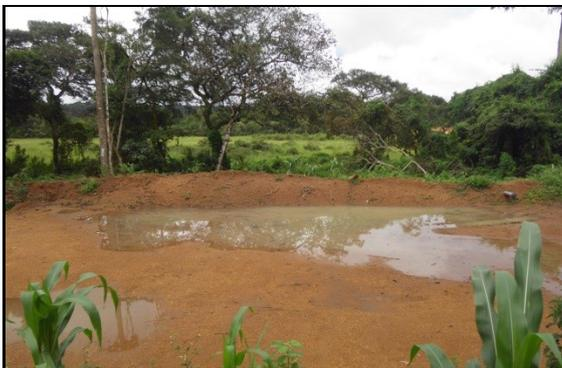
*LE BASSIN D'OXYDATION EN OCTOBRE, VIDE CAR L'EFFLUENT S'INFILTRE TOTALEMENT DANS LE BASSIN ANAEROBIE*
