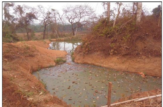
*CUISINES BVO: LE BASSIN ANAEROBIE SUIVI DU BASSIN D'OXYDATION EN ARRIERE PLAN*
