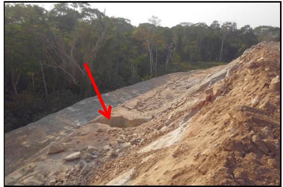
LE MEME ENDROIT EN FEVRIER 2015. NOTER L'EROSION DE LA BERME AU COURS DES DERNIERES PLUIES
