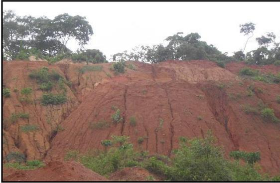
ZONE DE DEPOT N° 4 (FACE DIGUE DE COL) MONTRANT UNE EROSION ACTIVE ET UNE INSTABILITE (EN AVRIL 2014)
