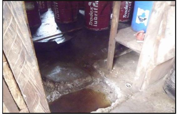
GAR. PRINCIP. : ASSURER ETANCHEITE DALLE-MURS ET CONSTRUIRE MURETTE 30 CM DANS L'ENTREE
