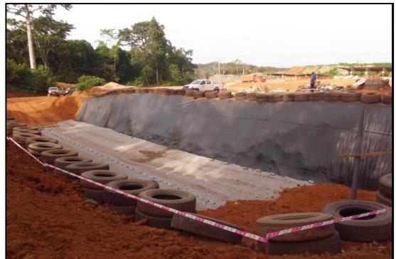
LES PNEUS UTILISES POUR STABILISER LA GEOMEMBRANE SERONT REMPLIS DE TERRE POUR EVITER L'ACCUMULATION D'EAU ET LE DEVELOPPEMENT DE VECTEURS
