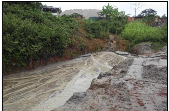
BASSIN INTERMEDIAIRE SOUS CONCASSEUR DEVANT ETRE REHABILITE
