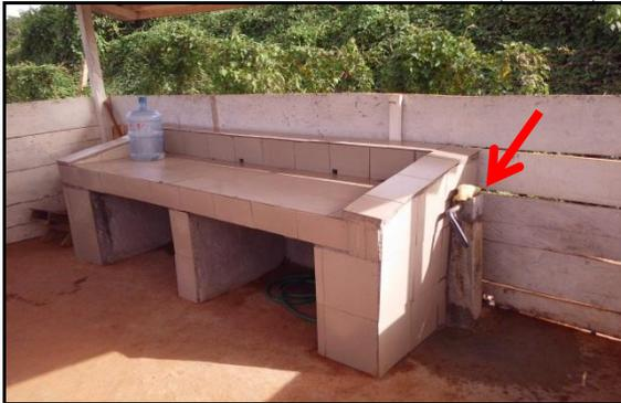
LE SEUL ROBINET POUR LE REMPLISSAGE DES BIDONS (A DROITE) N'ETAIT PAS PROTEGE CONTRE LES CONTAMINATIONS
