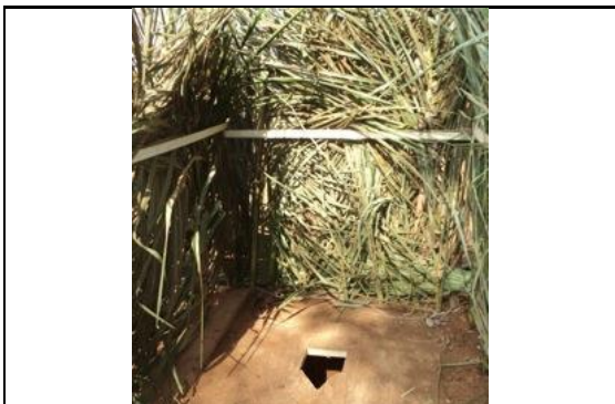
TOILETTE TEMPORAIRE SUR CHAQUE SITE D'ACTIVITE INSTALLÉE APRES REMARQUE DE L'ATESI
