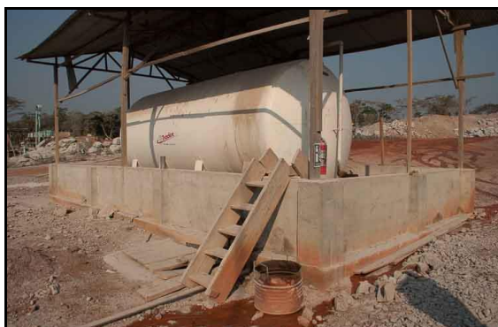
STOCKAGE GASOIL CONCASSEUR/CENTRALE BETON CONFORME ET BIEN ENTRETENU
