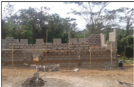
CONSTRUCTION DU POSTE DE CONTROLE MINFOF – LOM 2
