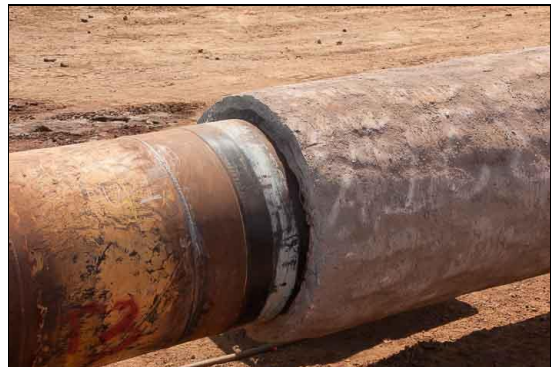
VUE DU RENFORCEMENT BETON DU TUYAU ACIER (EGALEMENT RENFORCE)
