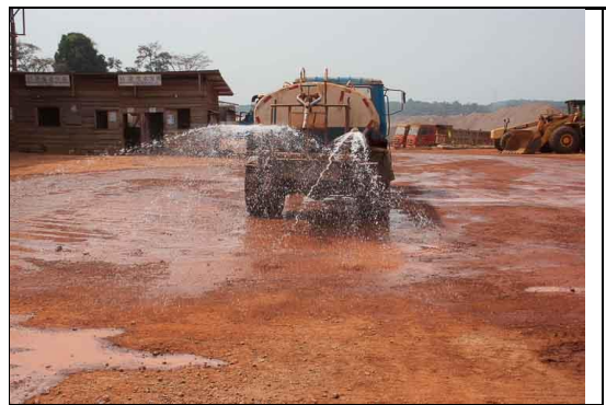
ARROSAGE REGULIER SUR SITES DE CHANTIERS
