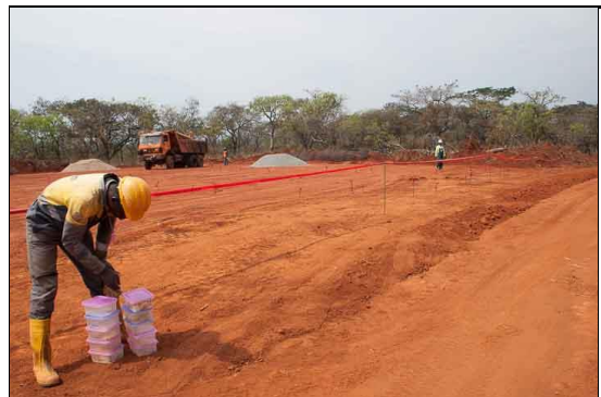
LIVRAISON DES LUNCH-BOXES AUX OUVRIERS SUR SITE (ICI NOUVELLE ROUTE DE CONTOURNEMENT)
