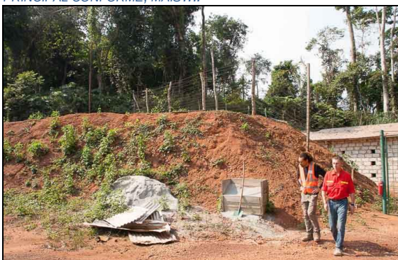
DIGUE DE SEPARATION ENTRE STOCKAGE EXPLOSIFS ET STOCKAGE DETONNATEURS (BATIMENT A DROITE) CONFORME
