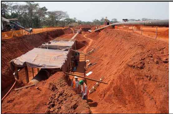
VUE GENERALE DU CHANTIER D'ADAPTATION DE L'OLEODUC
