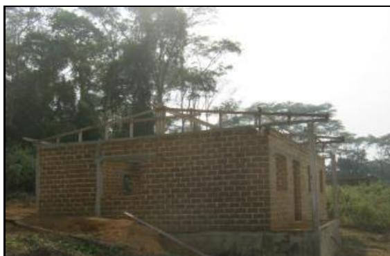
CHANTIER DE QUELQUES CONSTRUCTIONS ABANDONNE A LOM 2 PRES DE GOYOUUM
