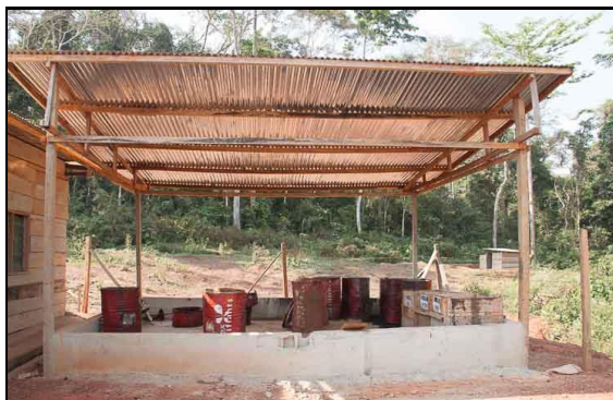
ZONE TEMPORAIRE DE STOCKAGE DE DECHETS DANGEREUX EN CONFORMITE (SAUF VANNE D'ECOULEMENT)
