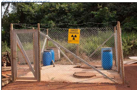
STOCKAGE DU MATERIEL RADIOACTIF DE RADIOGRAPHIE DES SOUDURES
