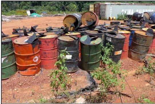
MAUVAIS STOCKAGE DE BIDONS D'ASPHALTE SUR SITE STOCKAGE BVC
