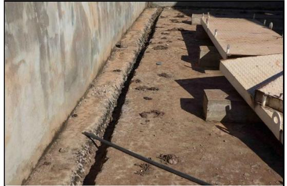
NETTOYAGE EN COURS DES DRAINS DU STOCKAGE CARBURANT
