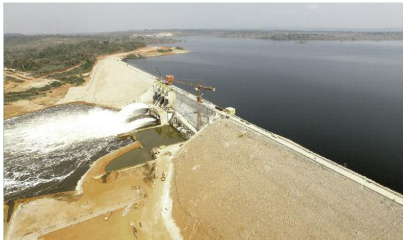
Le barrage de Lom Pangar en mars 2018.
